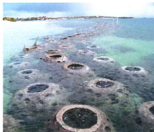
砂浜浸食防止潜堤
